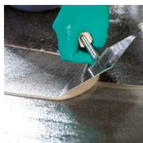
Schraap en uitvlaklaag MC-DUR TopSpeed SC opgevuld met zand
