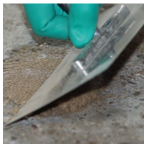
Opvullen van scheuren en spleten MC-DUR TopSpeed SC opgevuld met zand
